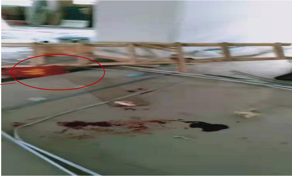
吴仕勇提供的事故现场图片
