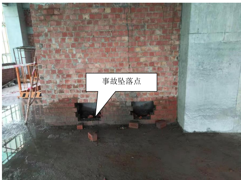
图 3 一楼排风井洞口照片
