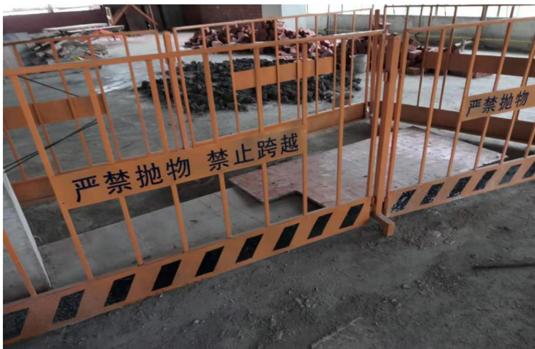
图 5 六楼排风井防护设施照片
