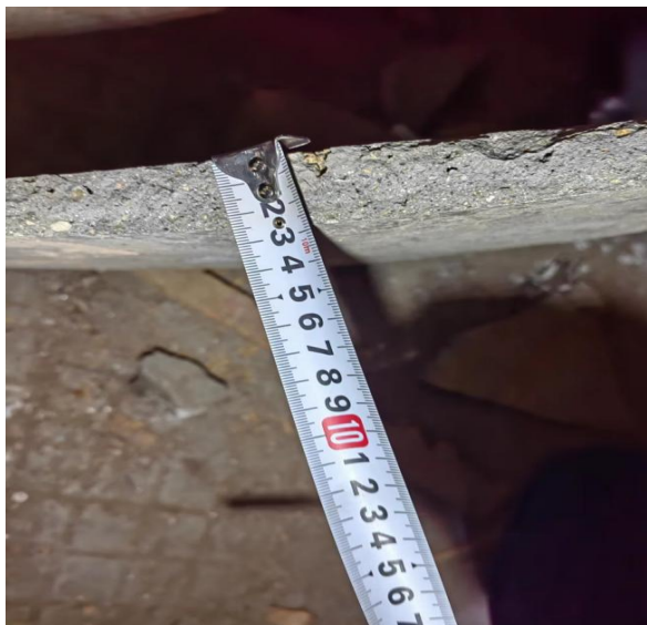
图 9 盖板水泥砂浆层断面
