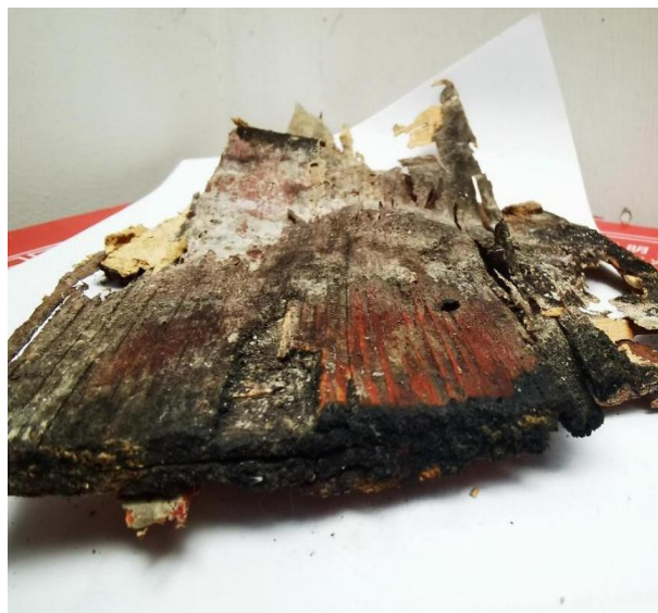
图 10 盖板底部模板残块
