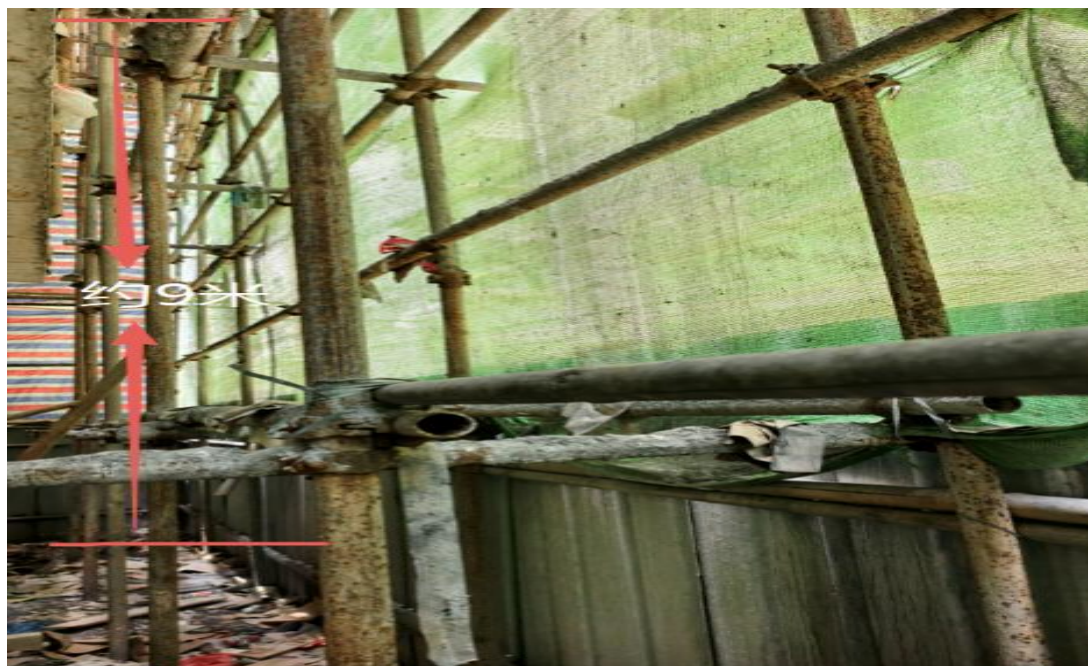
图 4 脚手架上离地面高度约 9 米
