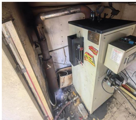
图 3 锅炉房内部图
