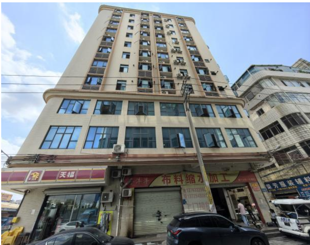
图 1 黄山公寓建筑现场图
