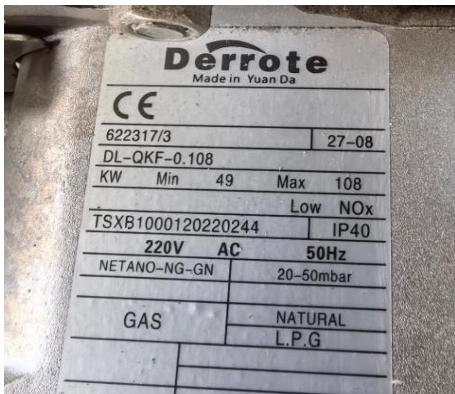
图 5 涉事锅炉燃烧机铭牌图
