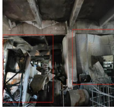
图 9 增加的简易隔墙现状图
