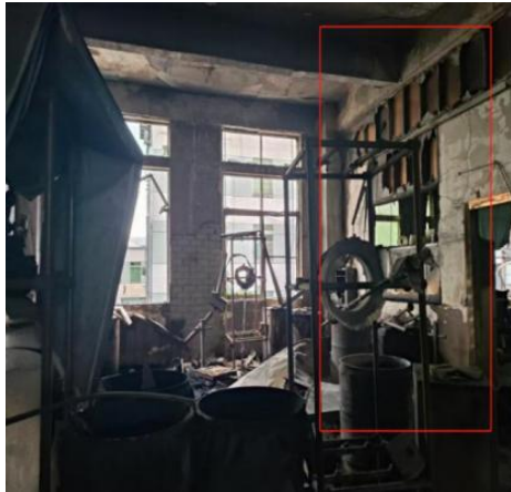
图 8 增加的简易隔墙现状图
