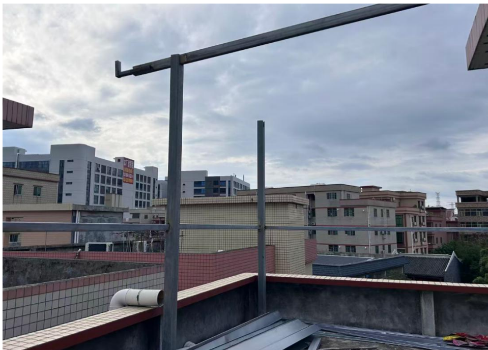
图 1 涉事房屋屋面建筑边沿
