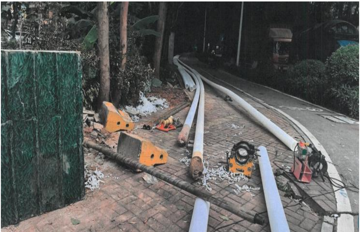
图 1 涉事施工现场图
