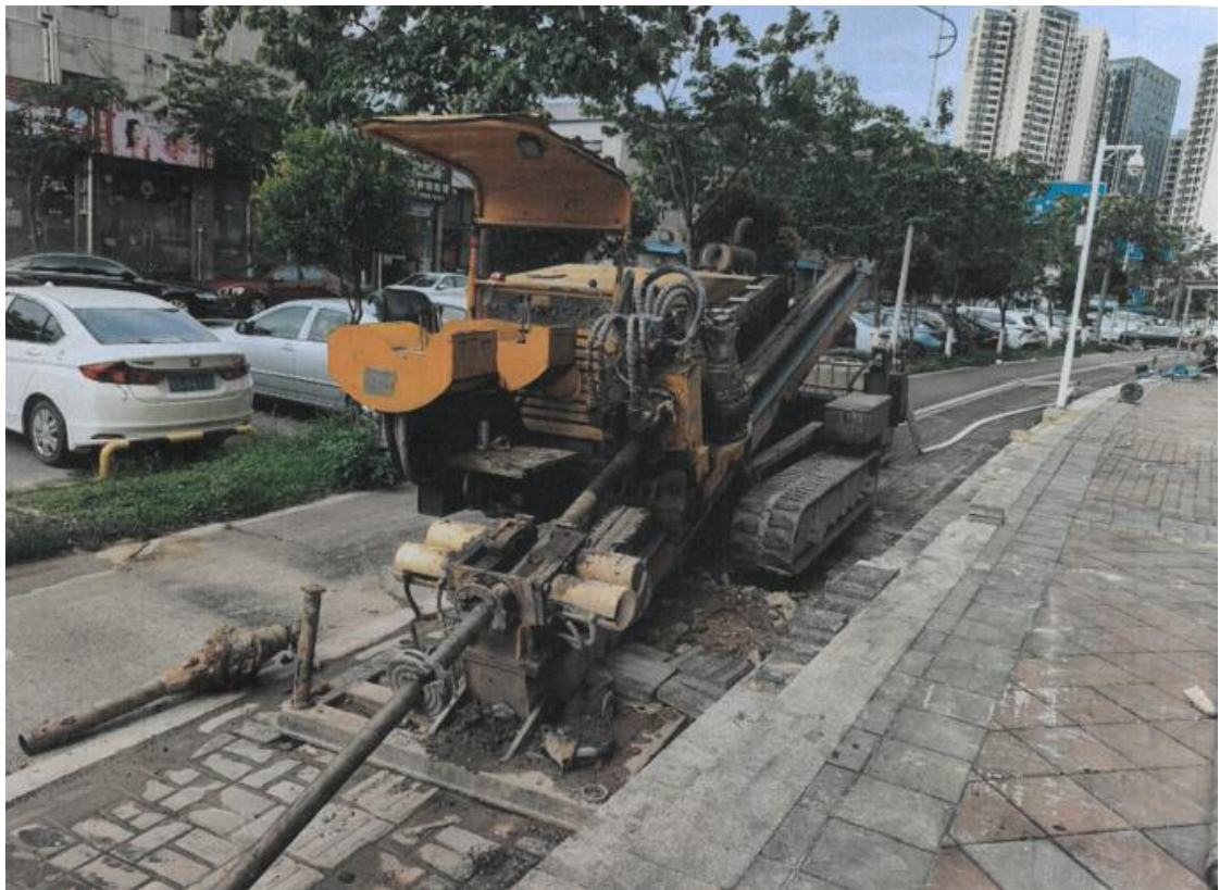
图 3 涉事施工现场设备（非开挖铺管钻机及钻杆）图
