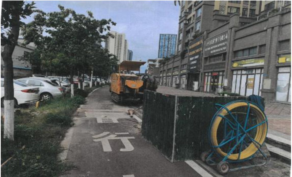
图 2 涉事施工现场图
