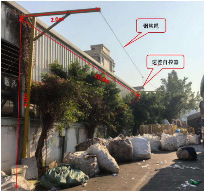
图4 水平生命线装置图
