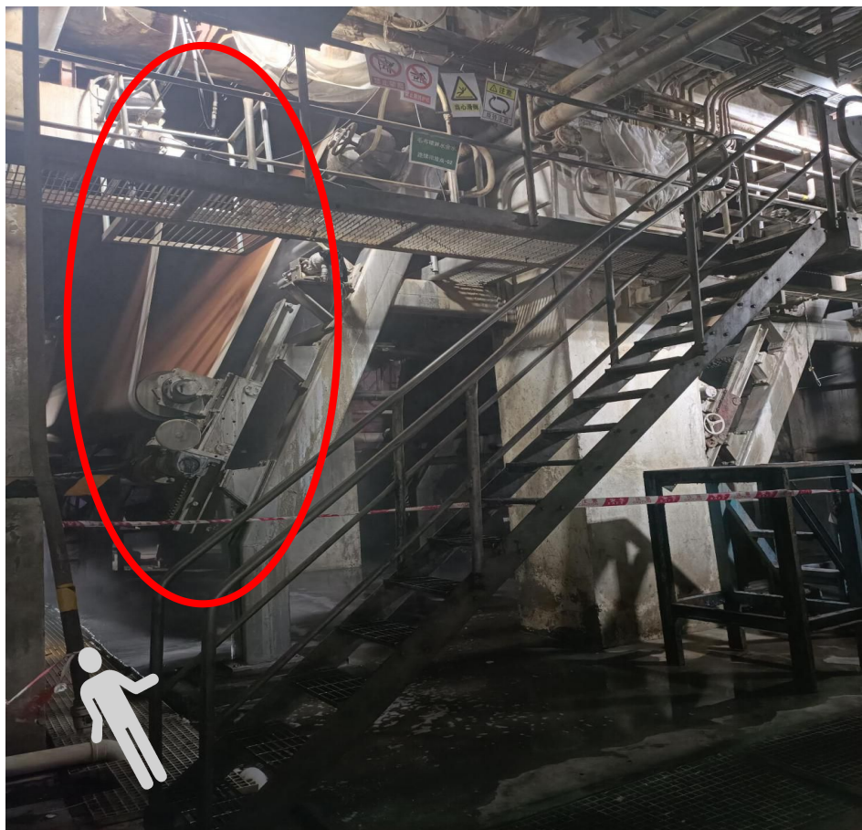
图 1 一楼压榨区域二压下及李世佐倒地位置
