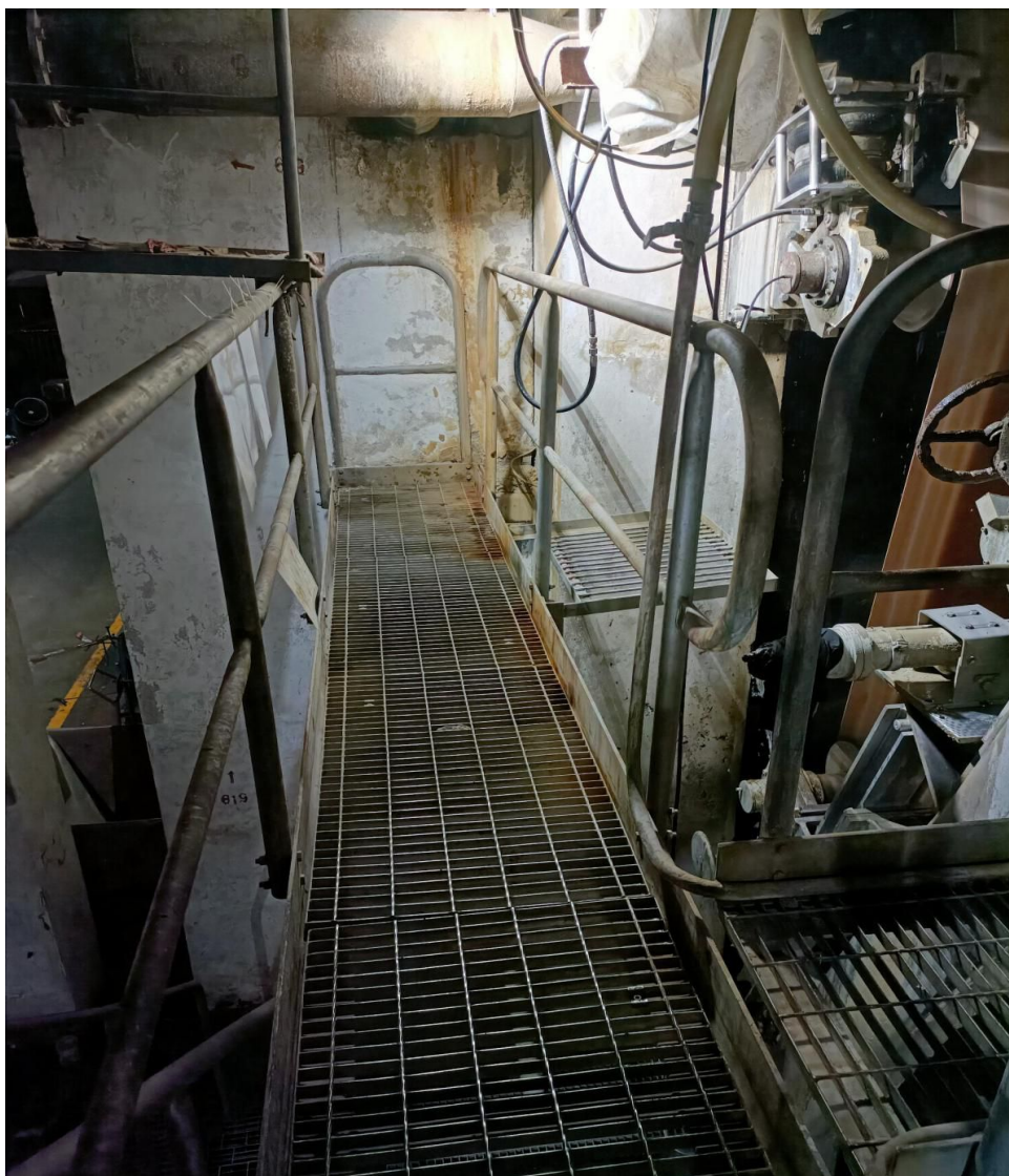
图3 一楼压榨区域巡检平台
