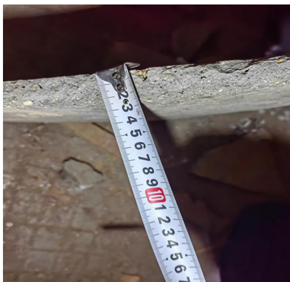
图 9 盖板水泥砂浆层断面
