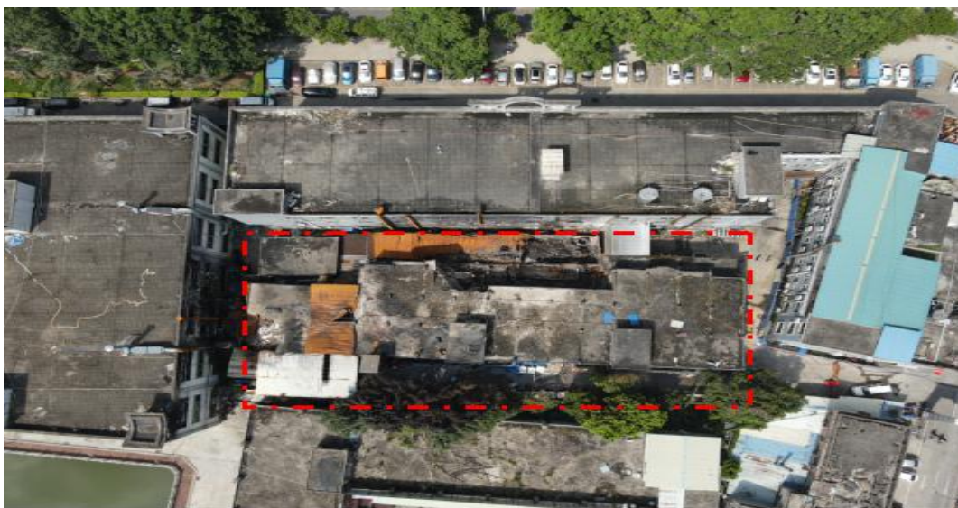
图 2 起火建筑厂区鸟瞰图
