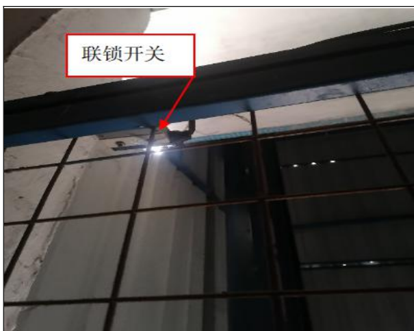
图 14 层门的联锁开关
