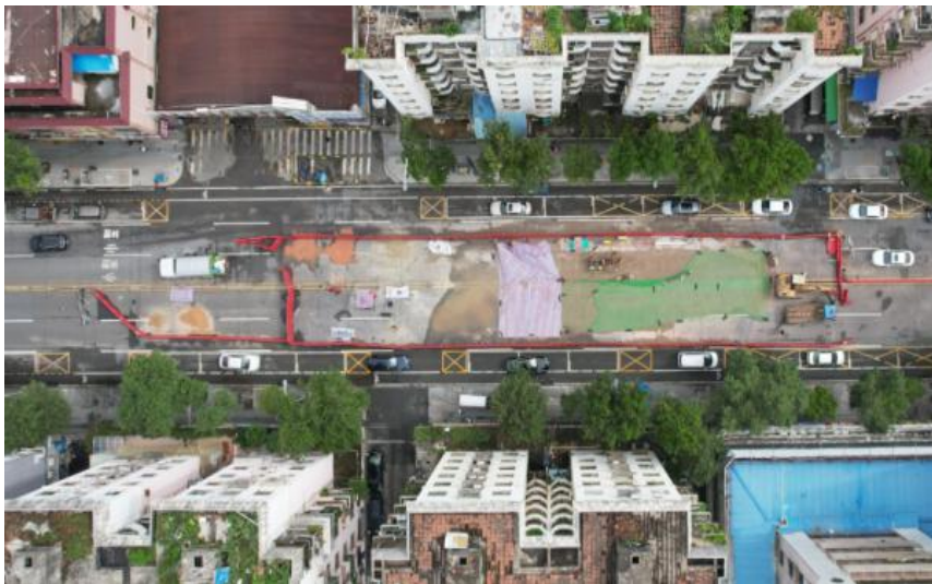
图4 事故现场回填
