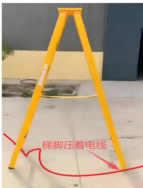
图 15 梯脚压在临时线路上的情景模拟 图 16 网线敷设作业的情景模拟
