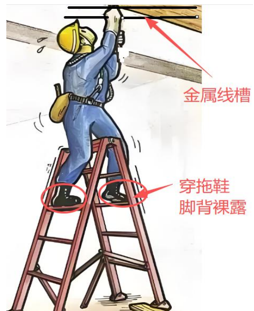
图 15 梯脚压在临时线路上的情景模拟 图 16 网线敷设作业的情景模拟
