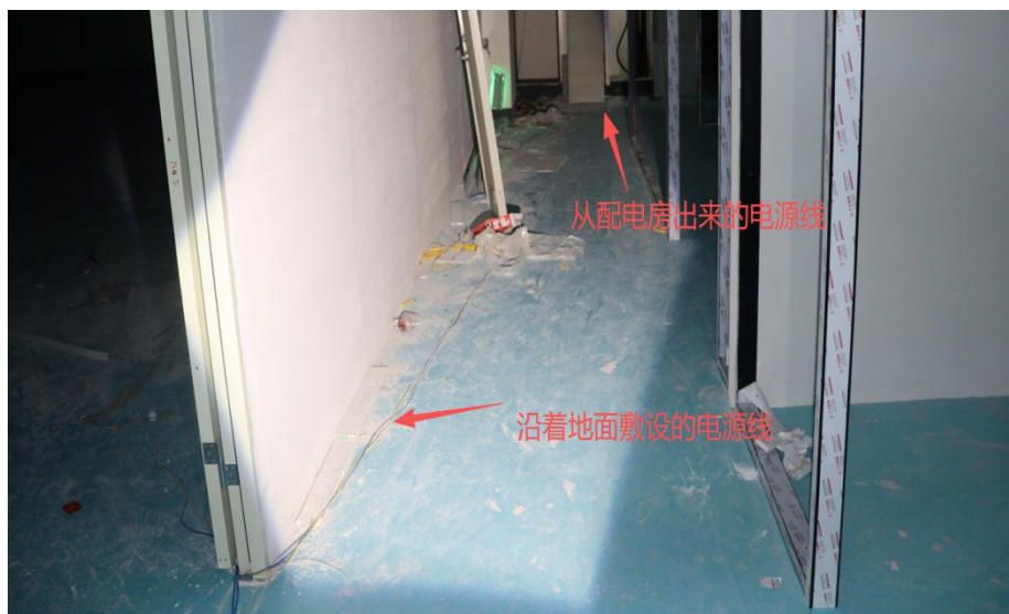
图 7 事发时地面上的电线情况
