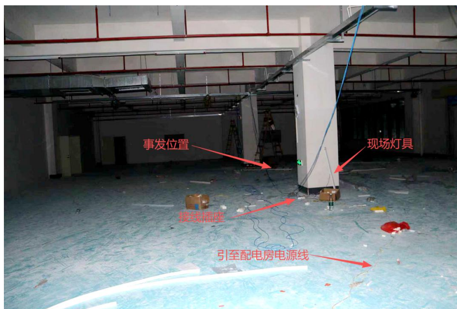
图 7 事发时地面上的电线情况
