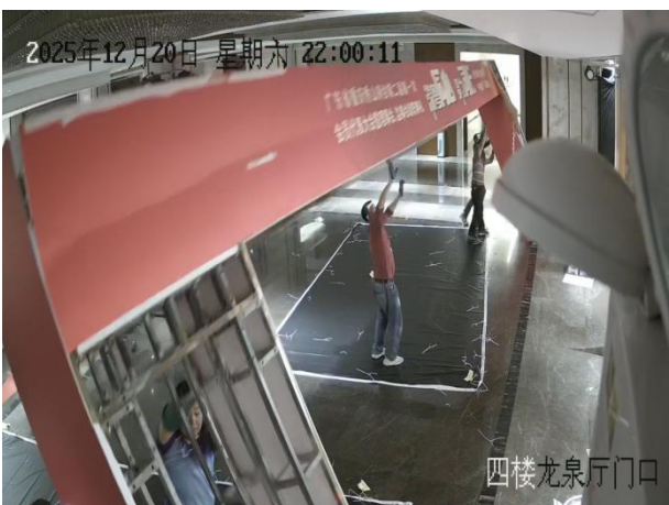
图9 柱脚发生滑动倾倒瞬间截图2
