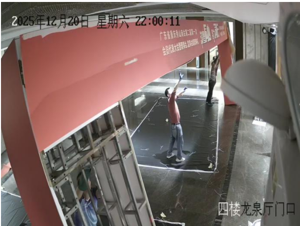
图7 柱脚发生滑动倾倒瞬间截图1
