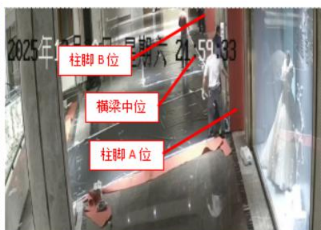
图 2 柱脚 A 位（监控近端）
