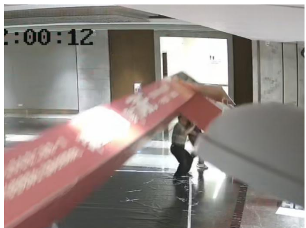
图10 柱脚发生滑动倾倒瞬间截图3
