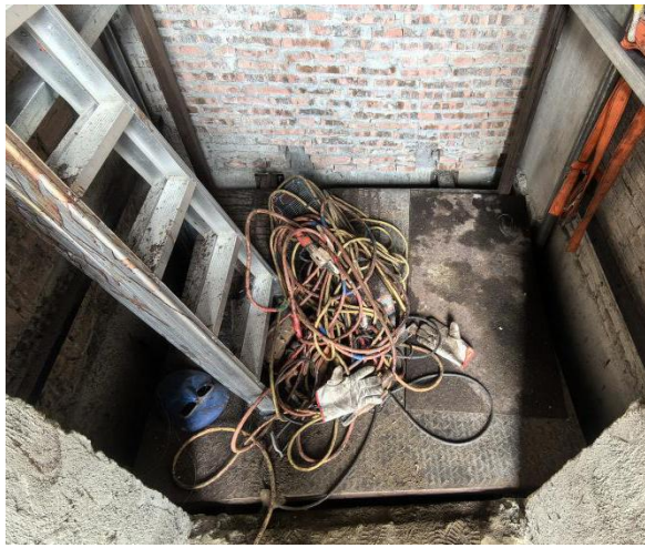
图 5 涉事设备的吊笼俯视图
