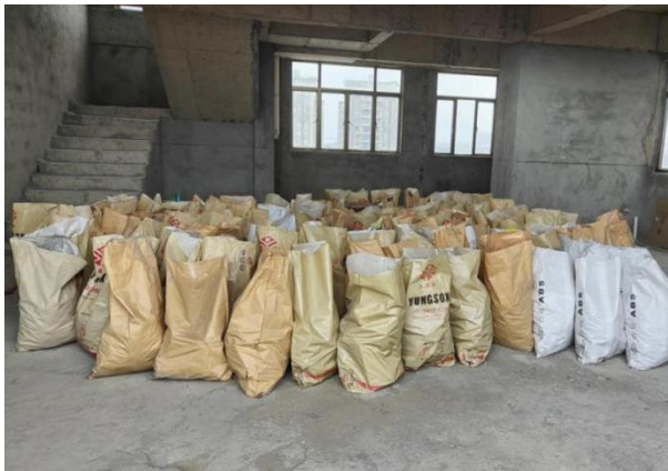
图2 美帮公寓 11 层堆放的建筑垃圾（整体图）
