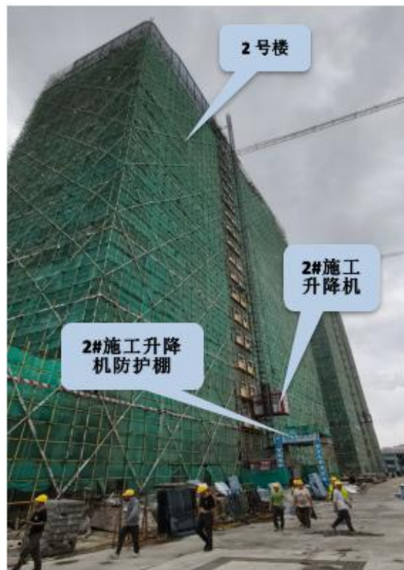
图 2 涉事项目西北侧 2-1 轴~2-14 轴立面图
