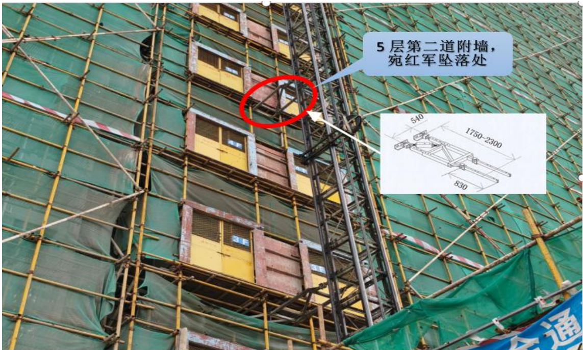
图4 第二道附墙示意图
