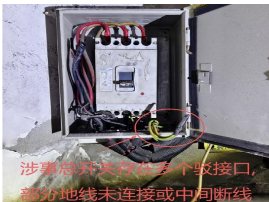
图 3 总开关处接线混乱
