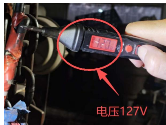
图8 驳接头外露线头带电情况
