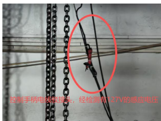
图9 电机电源及控制手柄电线驳 接头及地线脱落
