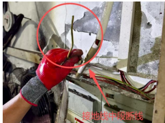
图 4 总开关接地线中段断线
