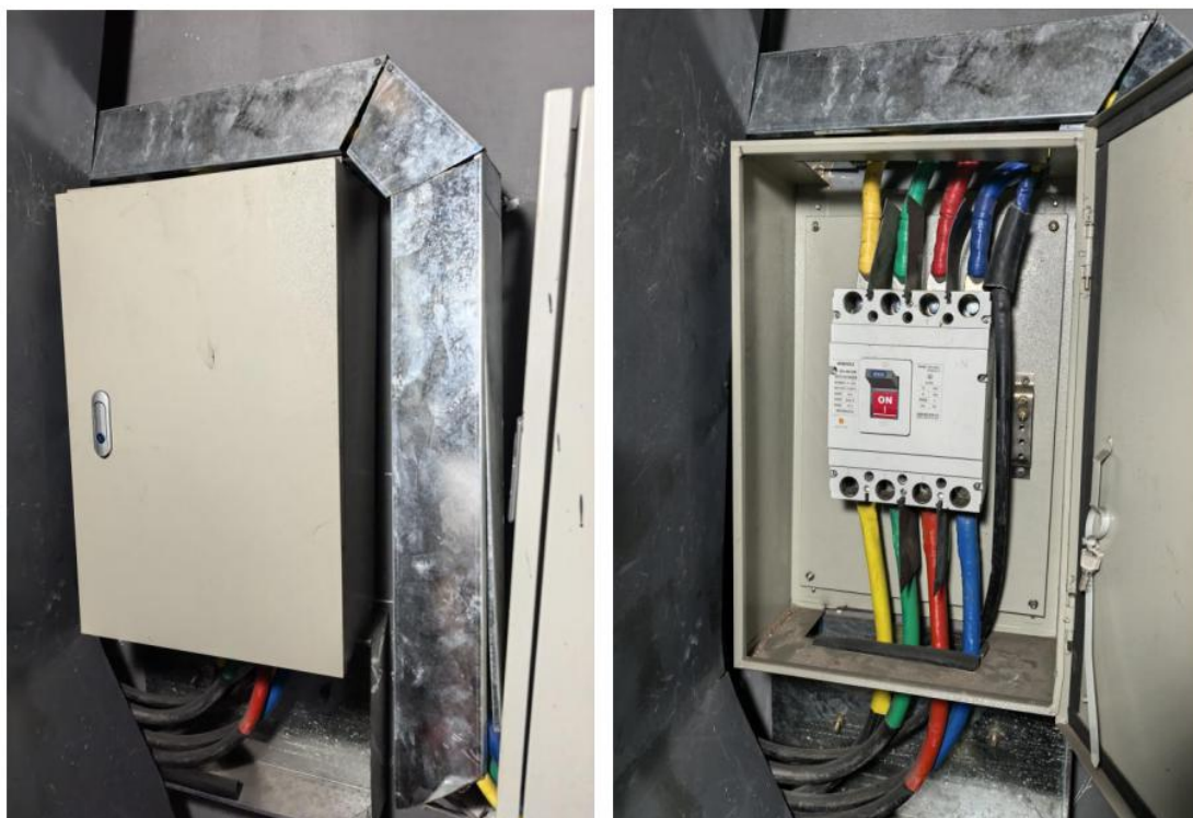
图 2 58 层新增电缆配电箱
