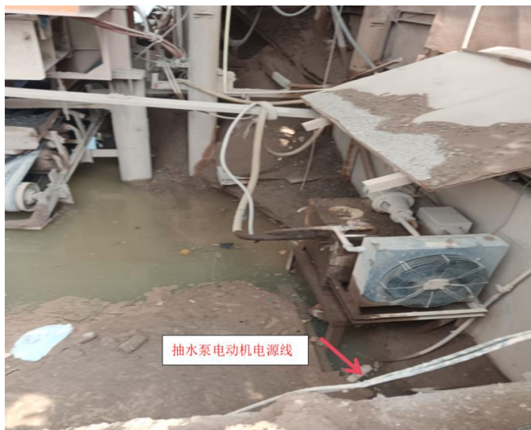
图 9 抽水泵电源线无护套保护
