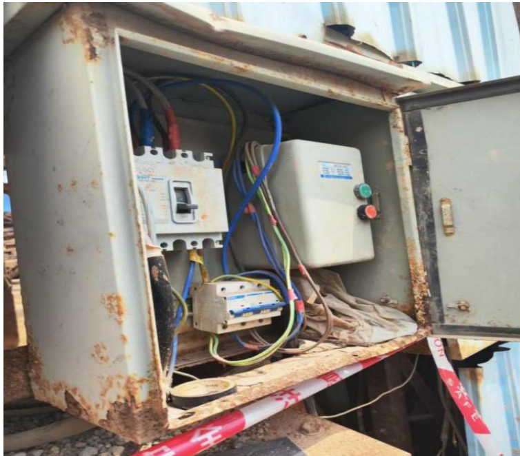
图 8 抽水泵配电箱图
