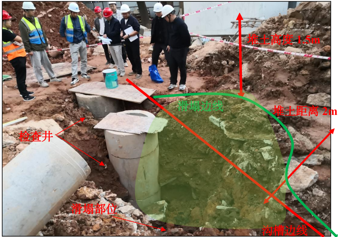
图 6 沟槽滑塌部位及周边堆土情况示意图
