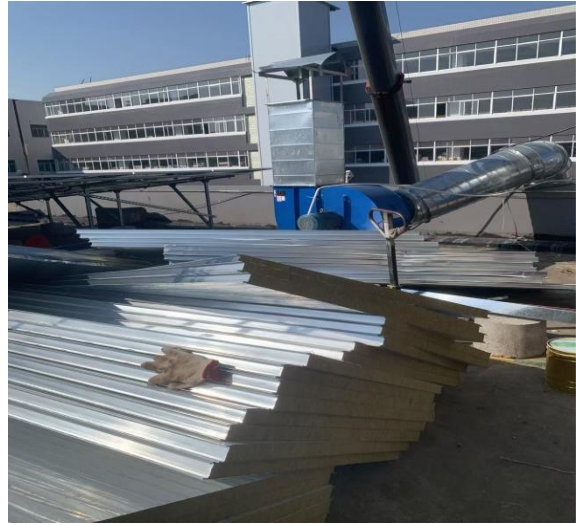
图 2 三楼天台及岩棉板照片
