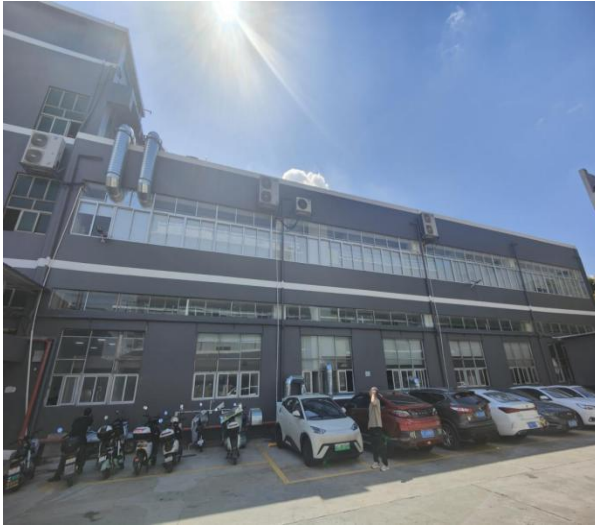
图 1 吊车作业场所
