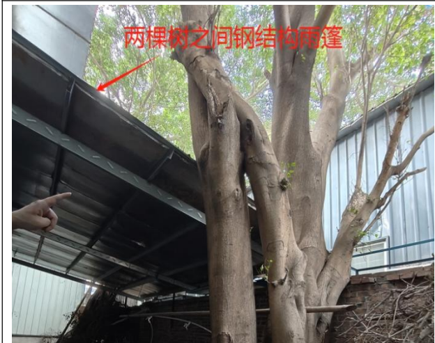
图 3 两树木之间钢结构雨篷
