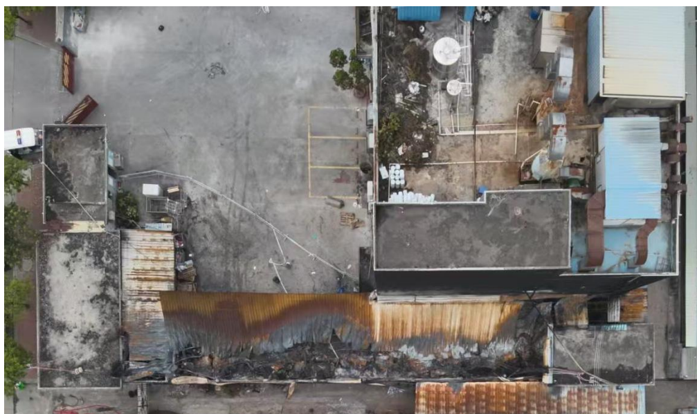
图 2 事故铁皮棚航拍图
