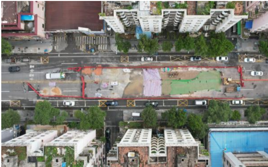
图4 事故现场回填
