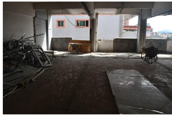
图 4 涉事项目四楼概貌
