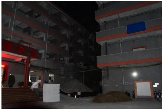
图 1 事故现场建筑物 [18]
