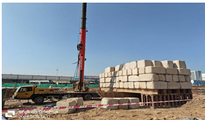
图 8 起重吊车与混凝土堆载试块位置情况
