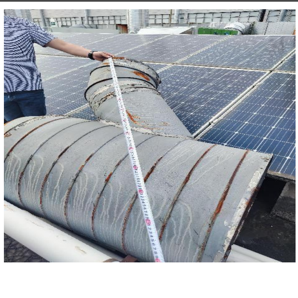
图 5 脱落的管道
