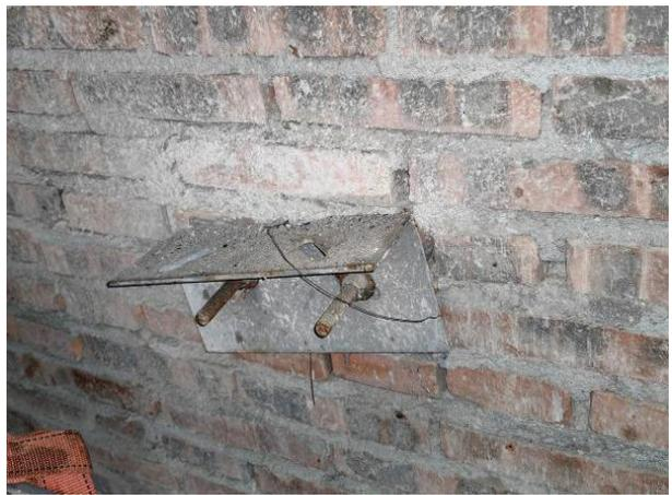
图 12 井壁长方形铁件
