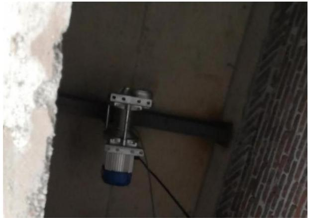
图 14 电动提升机吊挂在电梯井道顶部
