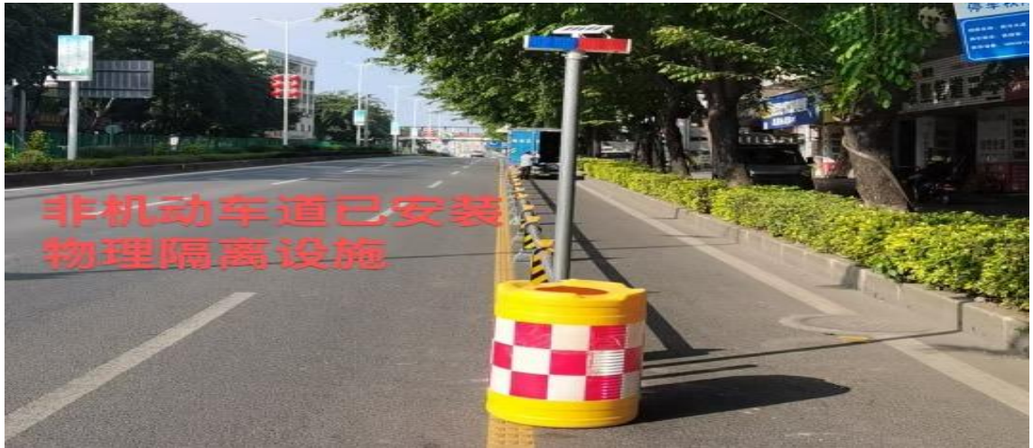
图 2 非机动车道已安装物理隔离设施图
