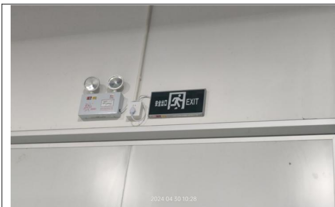
图 1 中走丝房应急照明灯和安全出口指示灯安装现场
