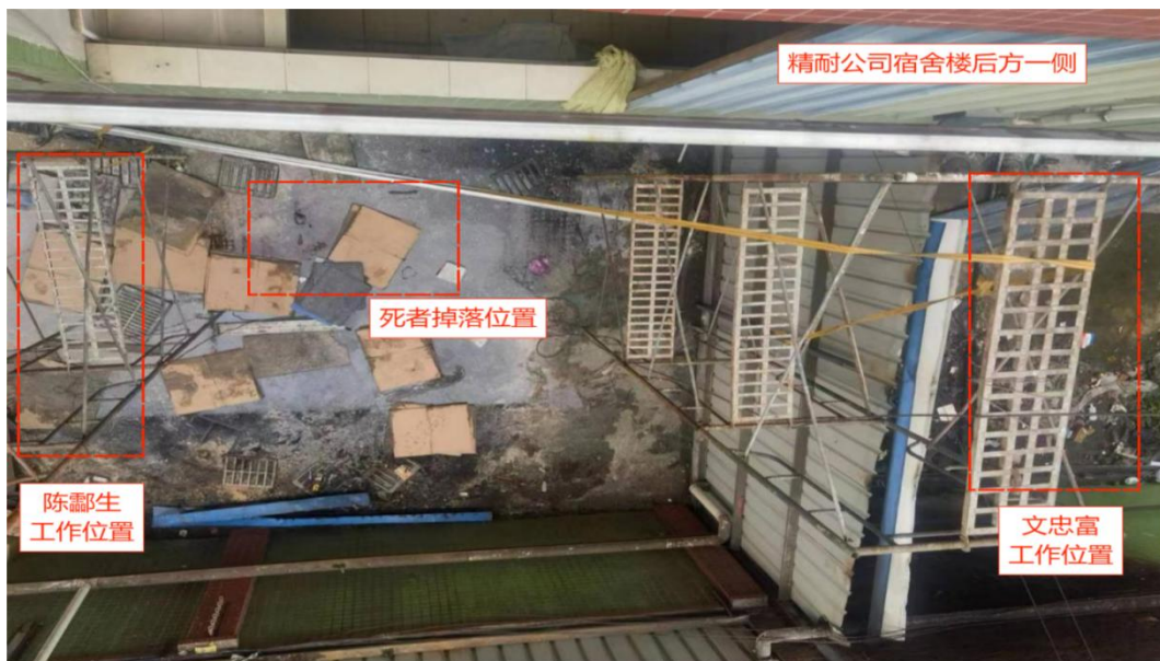
图 2 事故现场俯瞰照片
