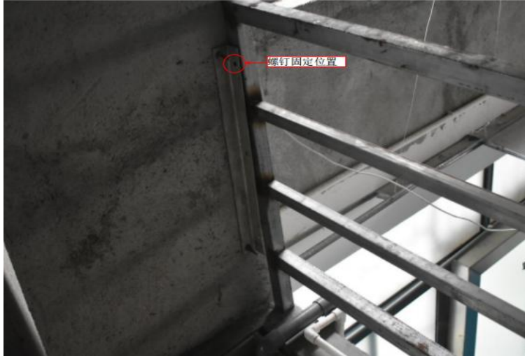
图6 防护栏杆安装在角铁外侧
