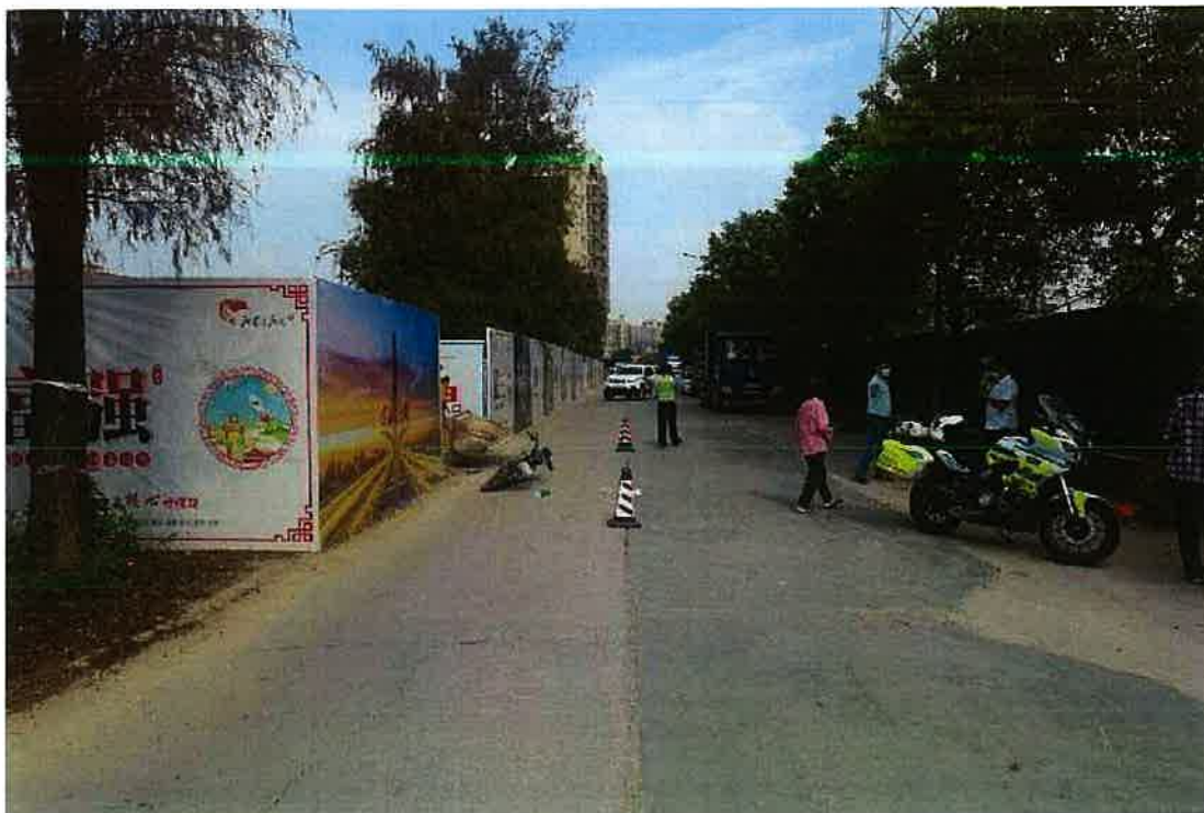
图3 事故现场道路未设置减速带和限速标志
